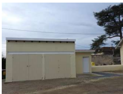
Peinture des garages situés en face du foyer municipal
